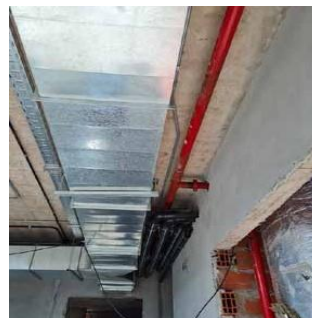
Avances de instalaciones de incendio y termomecánica en halles de ascensores y Núcleos I y II.
