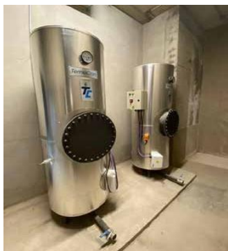
Posicionamiento de termotanques eléctricos en subsuelo del sector I
