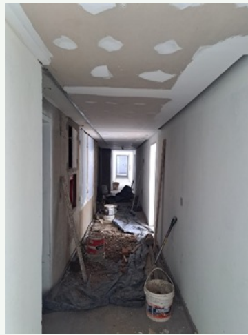
PASILLOS DE CIRCULACION 6° PISO.
