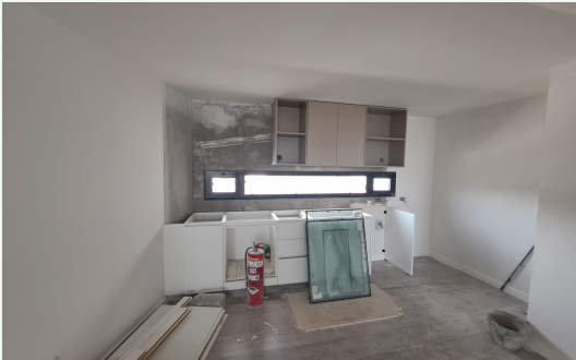
TERMINACIONES EN COCINAS.
