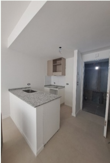
ESTADO DE DEPARTAMENTOS EN 3° PISO.
