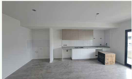
TERMINACIONES EN COCINAS.
