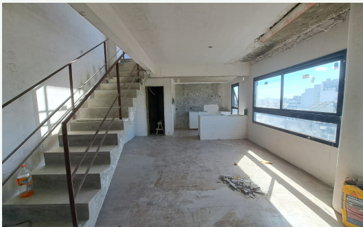
TERMINACIONES EN COCINAS.
