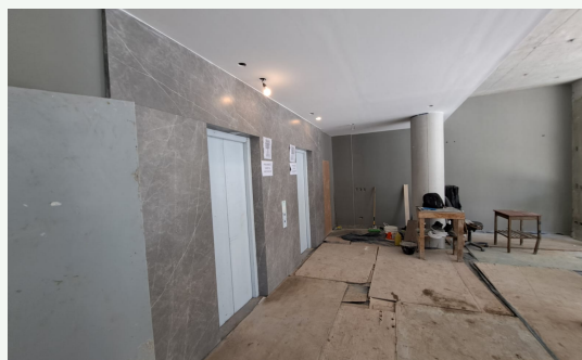
HALL DE ASCENSORES. PLANTA BAJA
