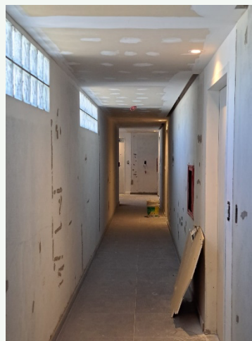
PASILLOS DE CIRCULACION 7° PISO.
