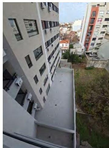
FACHADA CONTRAFRENTE 5° PISO.
