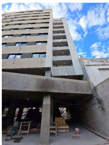
FACHADA CONTRAFRENTE PLANTA BAJA.
