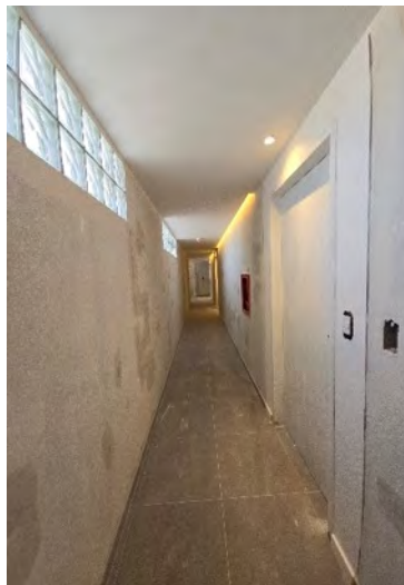
PASILLO DE ACCESO A DEPTOS. 9° PISO
