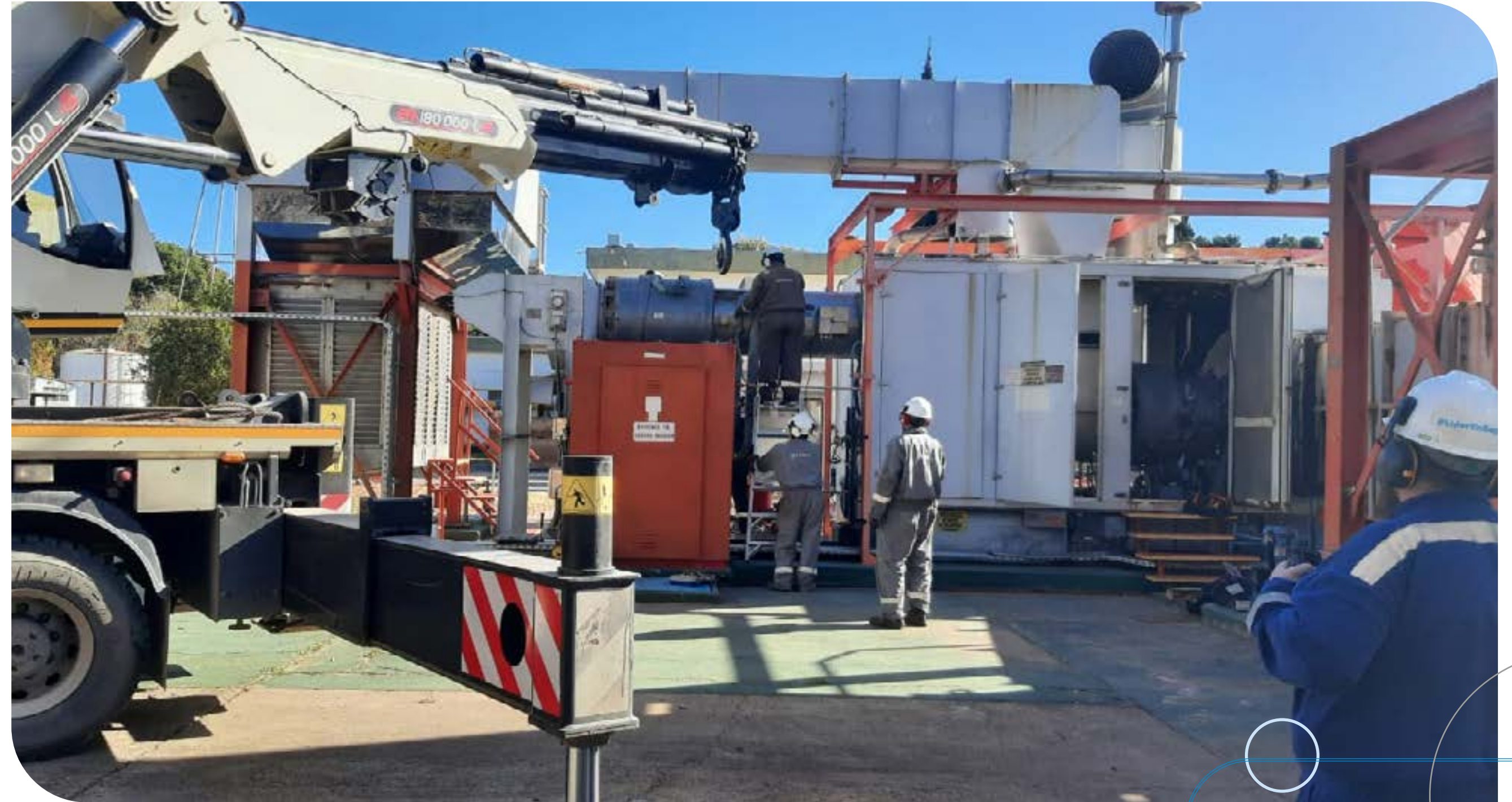
Completamos el 100 % de Service change/Overhaul de equipos turbobombas instaladas, asegurando la confiabilidad y disponibilidad del sistema, y garantizando horas de marcha remanente en equipos críticos.
