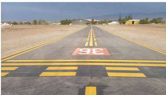
Se realizaron obras de rehabilitación de rodajes de acceso a los hangares en la zona sur del aeropuerto, la cual comprendió trabajos de bacheos, sellado de fisuras, demolición y reconstrucción de pavimento flexible y cambio altimétrico que permite la no acumulación de agua frente al Hangar.
