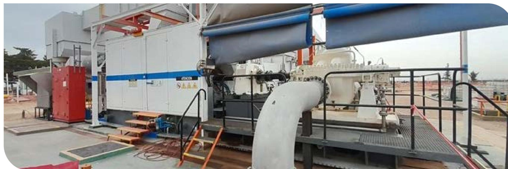
Ante las limitaciones de la inspección interna en cañerías enterradas en estaciones de bombeo, **se continuó con una amplia campaña de verificaciones directas**. Esta iniciativa nos permitió identificar daños por corrosión interna y externa, lo que condujo a realizar más de 100 excavaciones y 2 cambios de tramo, demostrando la importancia de esta estrategia para la identificación y mitigación de riesgos.
