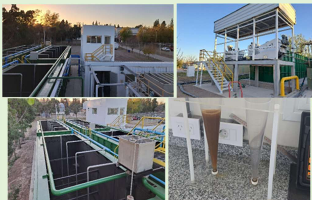
Nueva planta de tratamiento de efluentes líquidos en Arcor San Luis
