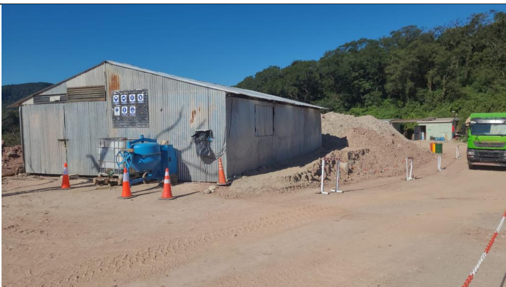
Zona 1: Galpón Obrador de construcción instalado
