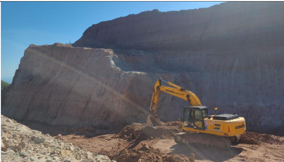
Vista general del Sector Cantera desde Producción
